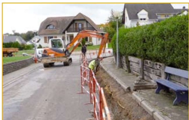
Enfouissement des réseaux secs
