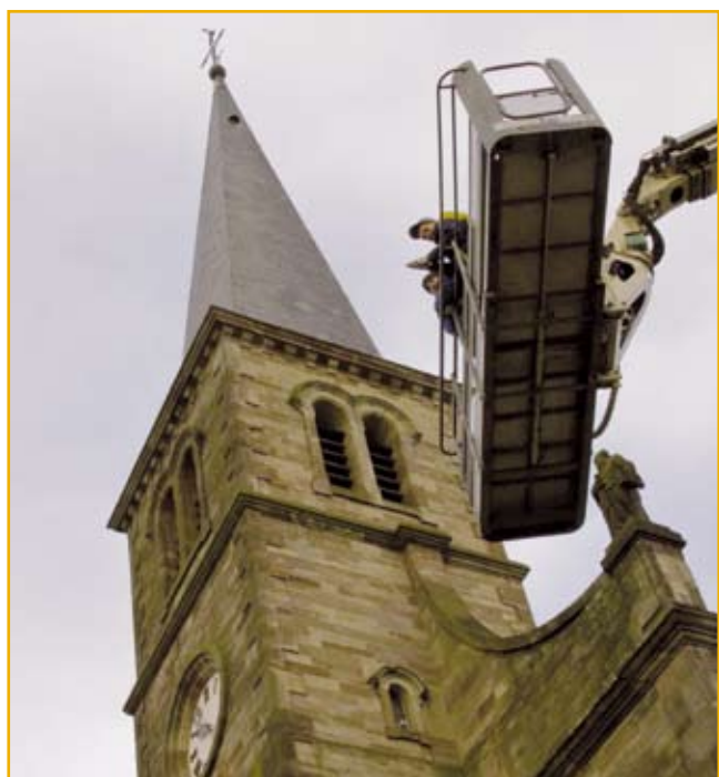
Réparation de la toiture du clocher : 3 900 € entièrement pris en charge par l'assurance Entretien et réparation des cloches : 10 930 €
