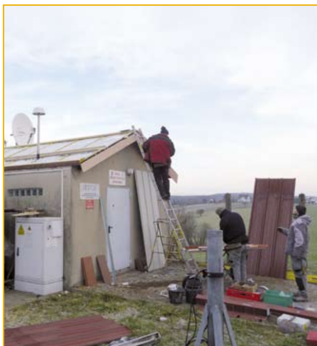
Réfection du toit de la station de tête : 3 750 € entièrement pris en charge par la Régie de Télédistribution
